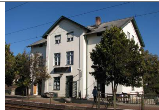
Zebegényi Vasútállomás mai állapota
