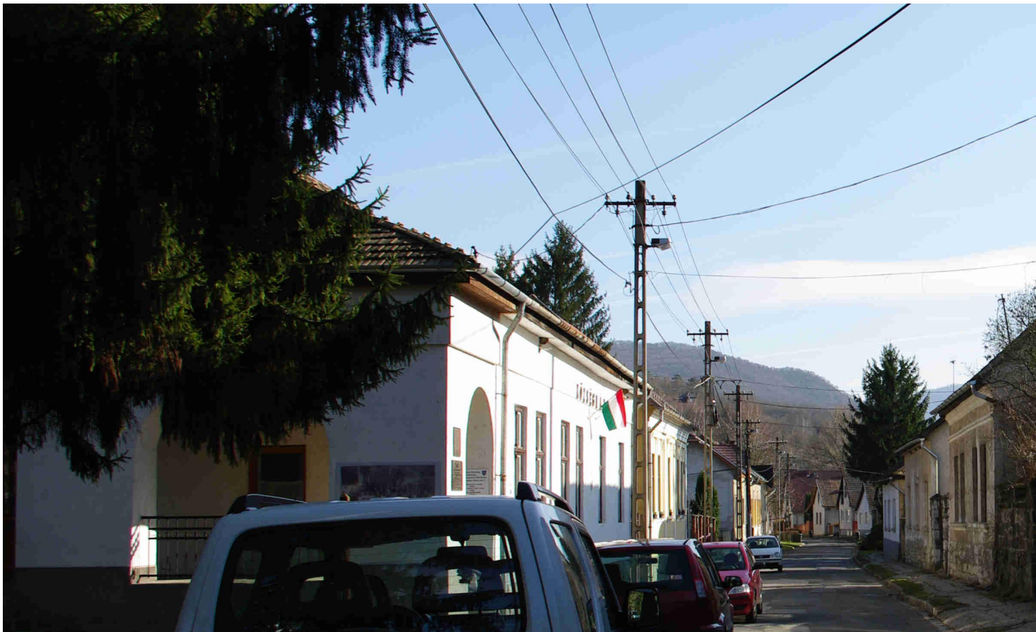
Árpád utca 5. Polgármesteri Hivatal épülete homlokzat, tömeg, tetőszerkezet, stílusjegyek
