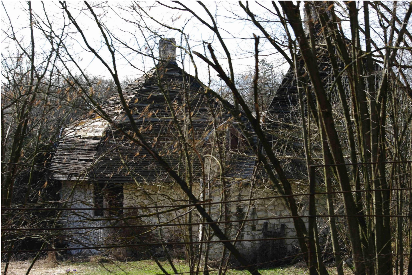
Lakóépület, műhely Márianosztrai út 21/c. hrsz.: 208 homlokzat, tömeg, szerkezet, tetőfedés anyaga, iránya
